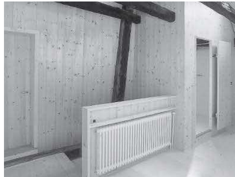
Links: Stube 1.10, Zustand nach der Restaurierung, Juli 2005. Rechts: Raum 2.01a, Zustand nach der Restaurierung, Juli 2005. KDP Fotoarchiv.
