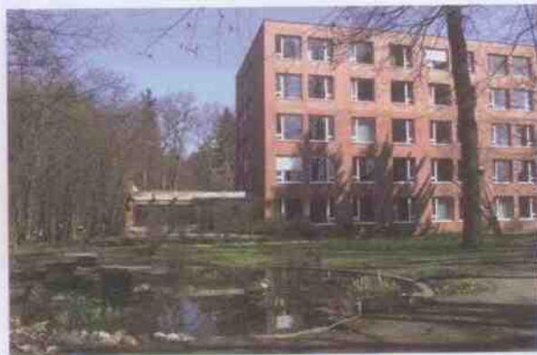
1985 wurde der Bettentrakt B um zwei Etagen aufgestockt.
