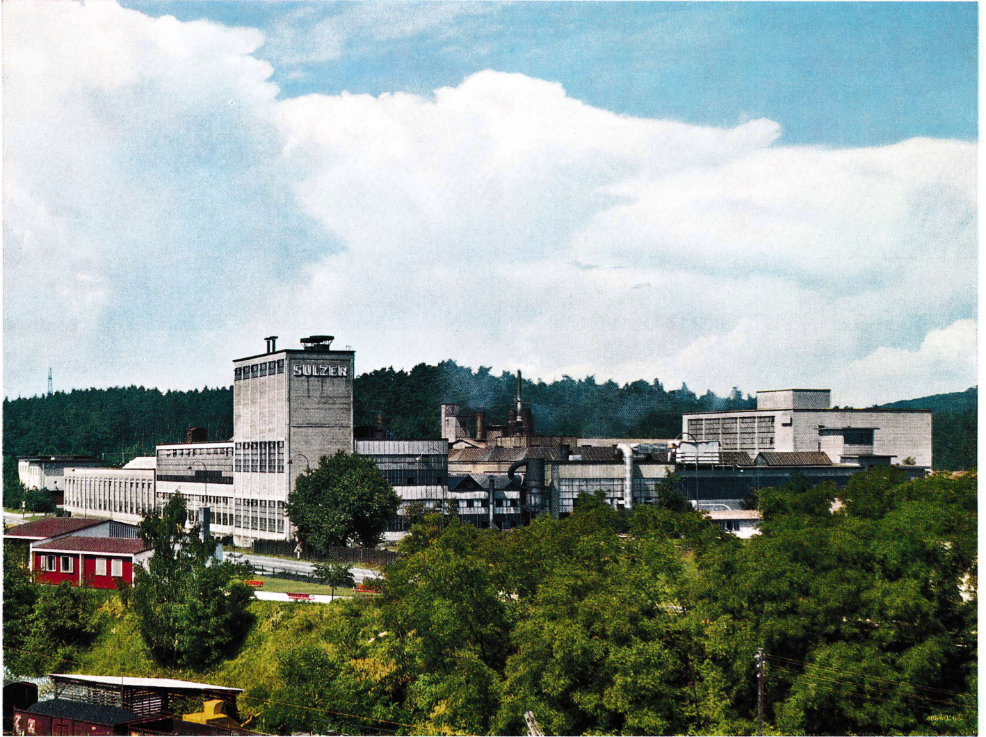
Werkanlage der Gießerei Bülach von Gebrüder Sulzer
